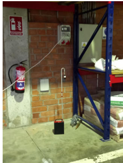
Magatzem - Mn-A4 - paret prestatges
