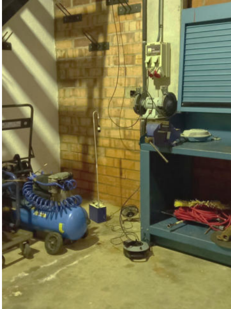
Magatzem - Mn-A1.2 - paret porticons, zona banc de treball
