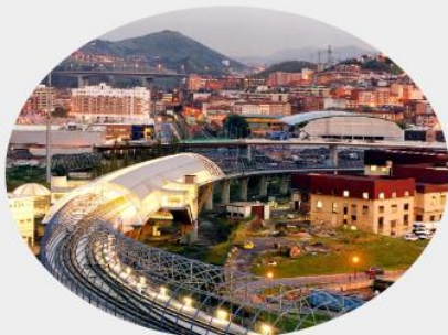
P6. ESTACIÓN INTERMODAL DE TRANSPORTES DE URBINAGA
