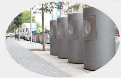
P5. GESTION RESIDUOS URBANOS / SISTEMA RECOGIDA NEUMÁTICA
