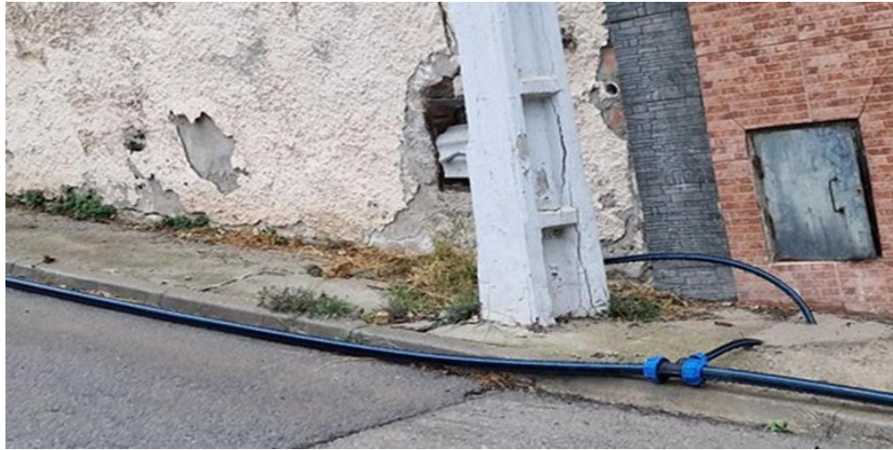
Tram de xarxa d'abastament en superfície en l'urbanització de Mas Milà
