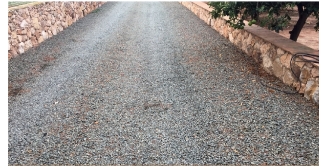
Vials fase I. Paviment provisional
