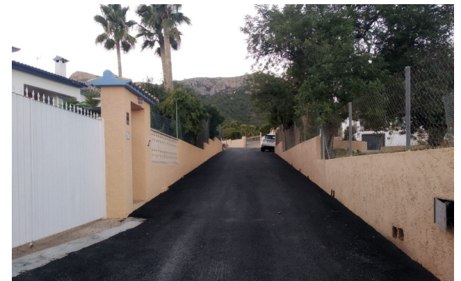
Vials fase I. Paviment provisional
